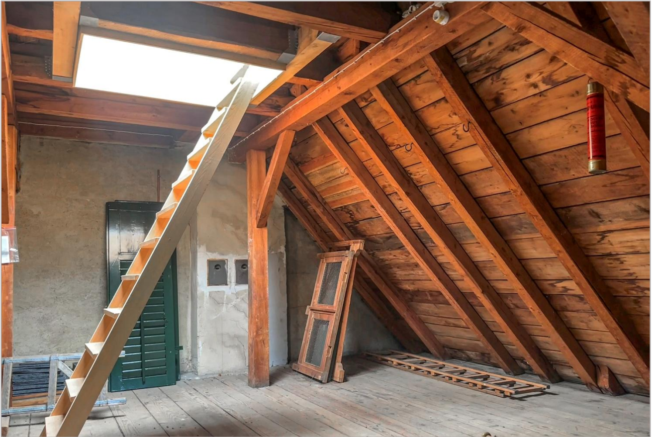
Dachgeschoss mit Ausgang zur Zinne
